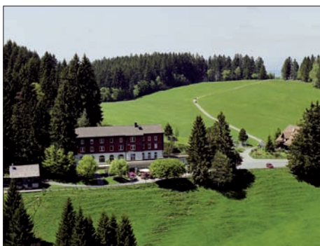
Restaurant, Ferien- & Lagerhaus Gottschalkenberg
