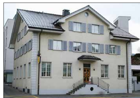
Vor dem Umbau: Restaurant Kreuz – Luzernerstrasse 1
