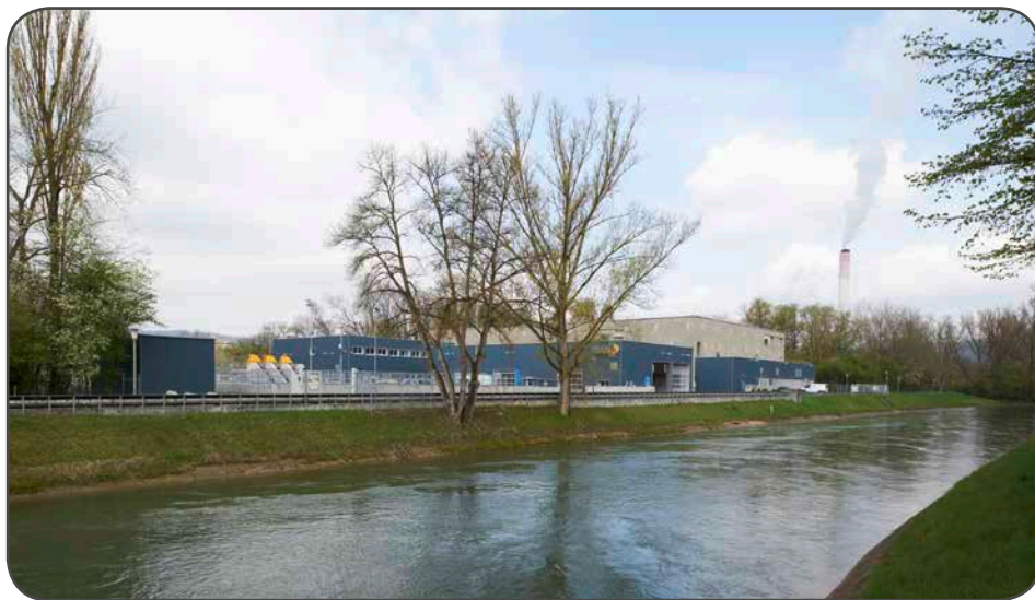
Abwasserreinigungsanlage: Mit der Wärme aus dem Limmattaler Abwasser heizt Limeco einen ganzen Stadtteil.
