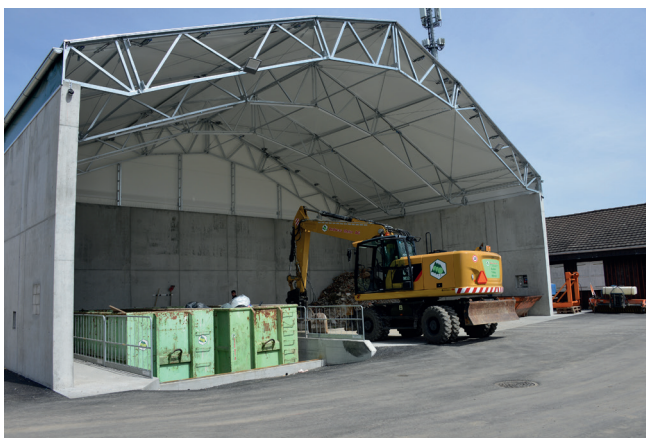
Die neue Entsorgungsanlage Niederamt in Winznau
